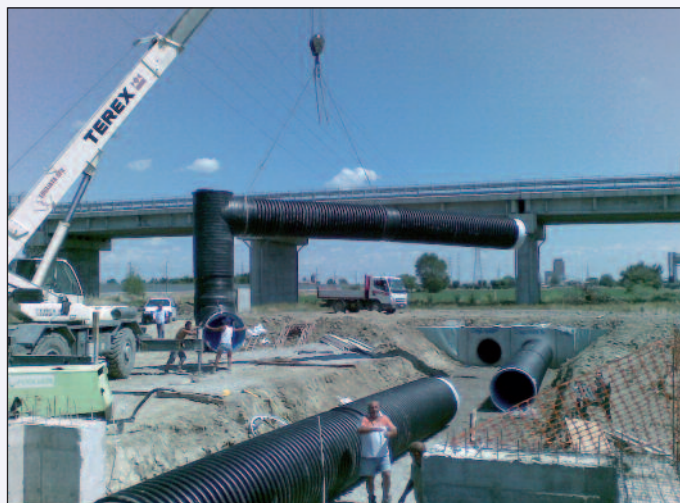
Figura 4 - L'installazione dei tubi SGK per il sifone di attraversamento dell'Autostrada A1 a Parma
